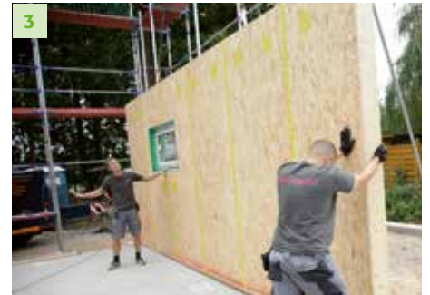
3 Montage der Holzbau-Elemente vor Ort.
