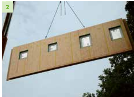
2 Per Kran wurden die Elemente an die richtige Position gebracht.
